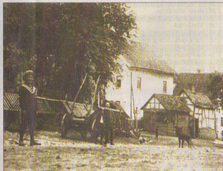
Queckborns Dorfmitte um 1910 – das Spritzenhaus wurde 1923, das Backhaus 1938 abgerissen.
